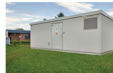
02. BT - Gebäude (Quelle: Betonwerk)
